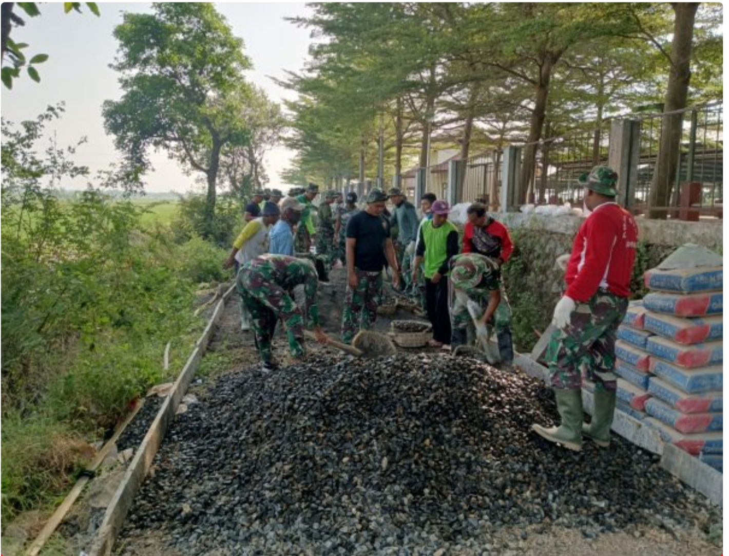
Foto istimewa ( Satgas tmmd reg 116 kebut pengecoran jalan
